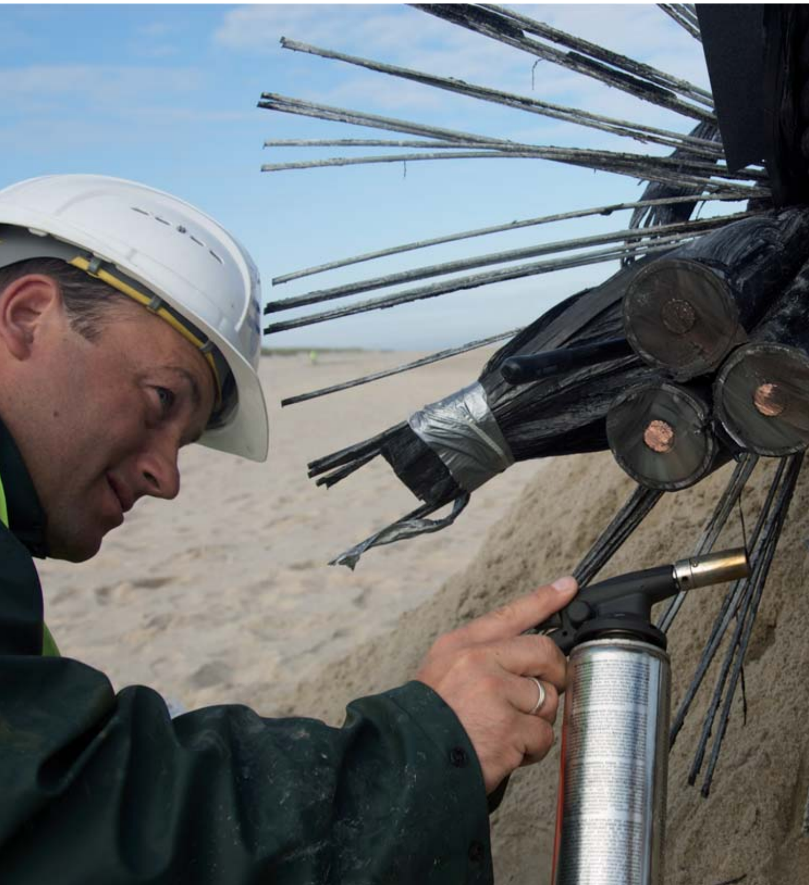
Photo: Stiftung Offshore-Windenergie
